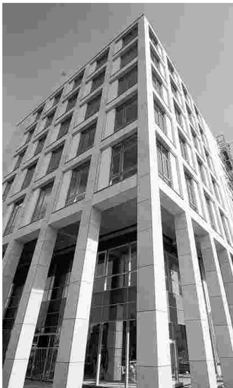
Neuer Blickfang im Ostviertel: Die Aachen-Arkaden – hier der prägnante Büroturm – eröffnen in weniger als drei Wochen. Foto: Wolfgang Pitzner
